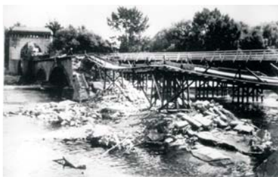
Foto: Behelfsbrücke für die von der SS gesprengte Isarbrücke
